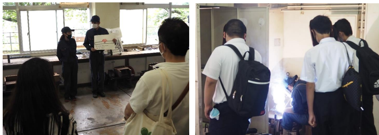
被覆アーク溶接機による溶接作業の実演と解説
